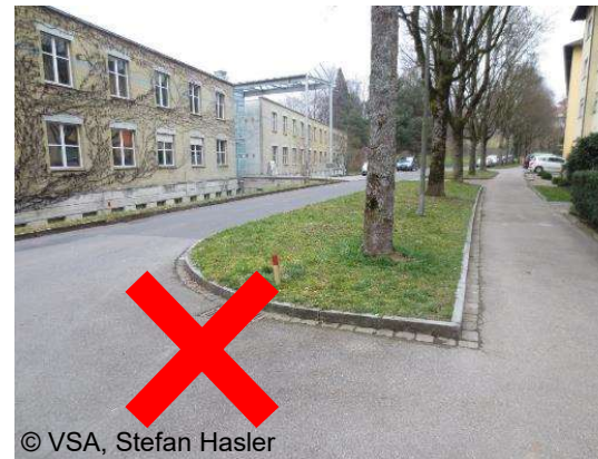
Strassenbegleitgrün absenken, erhöhte Randabschlüsse meiden
